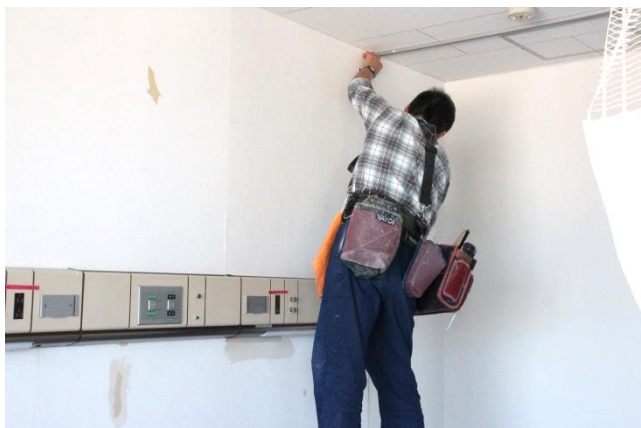
南館大部屋の壁紙を張り替え(2018.11) 汚れや破損のあった壁紙を張り替え、とても明るく清潔になりました。
